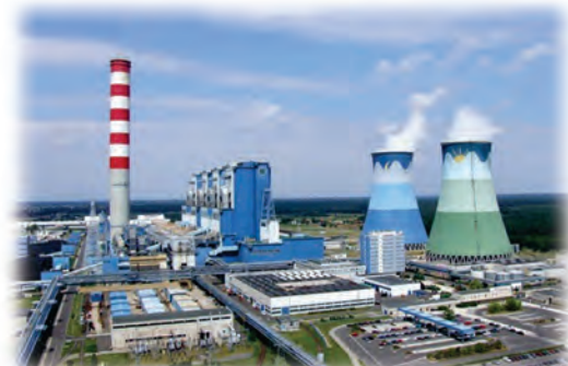
Электростанция Ополе Ополе, Польша
