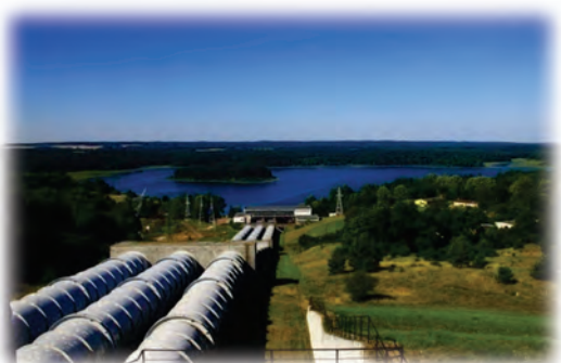
Насосная электростанция Жидово Жидово, Польша
