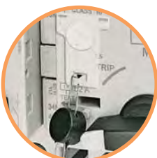
→ Пломбувальна панель регулювання теплового захисту
